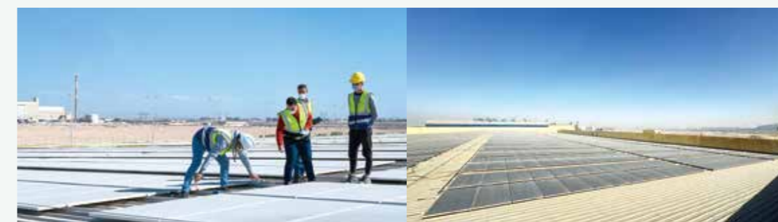
巨石埃及建设光伏发电项目
