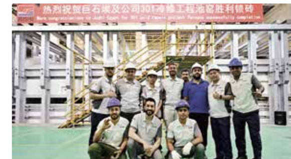
巨石埃及301线冷修工程胜利锁砖。
