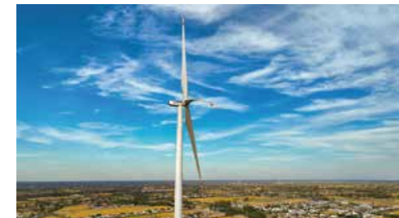
吊装完成的风力发电机组。
