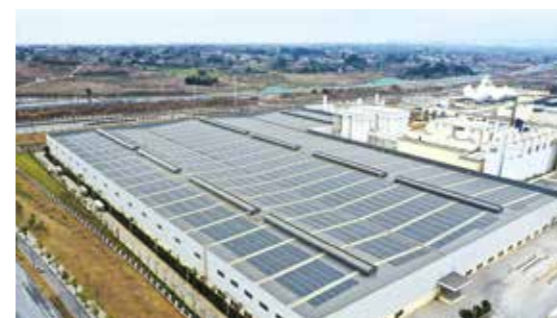
巨石成都智能制造基地投运了成都最大11.6兆瓦分布式光伏电站。
