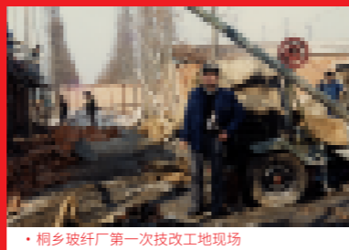
• 桐乡玻纤厂第一次技改工地现场
